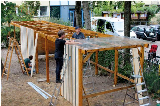
Mitarbeitende beim Bau der Wintergarage
